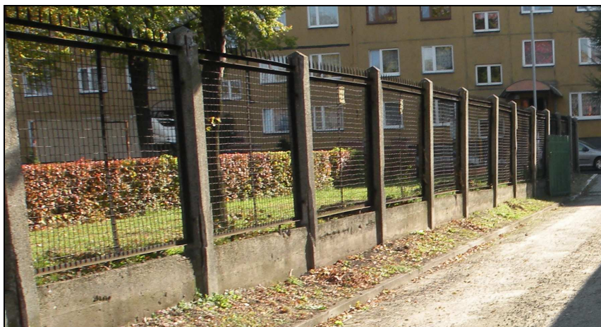
FOT 3. Widok ogrodzenia terenu od strony wschodniej działki
